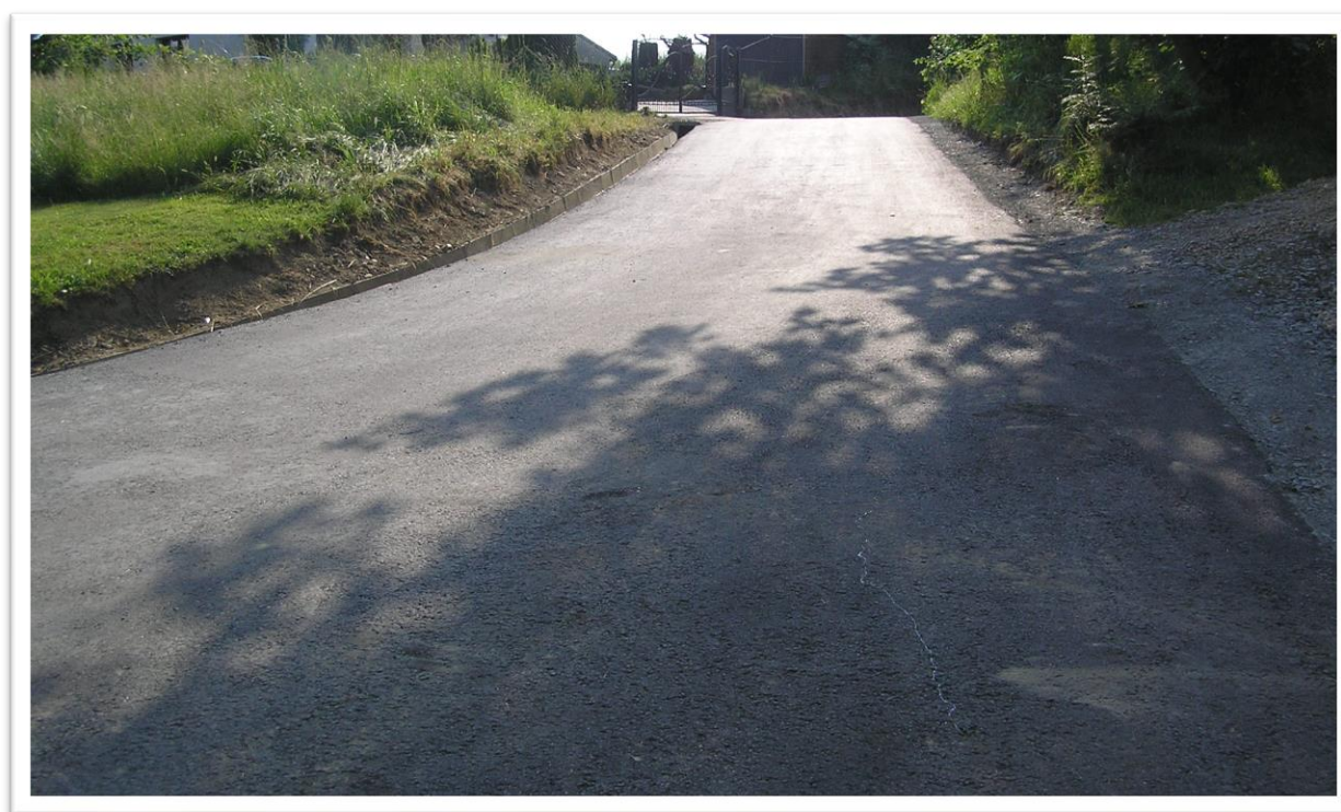
Fot. 2 Remont drogi rolnej Ciapałowa w Bystrej Podbalańskiej
